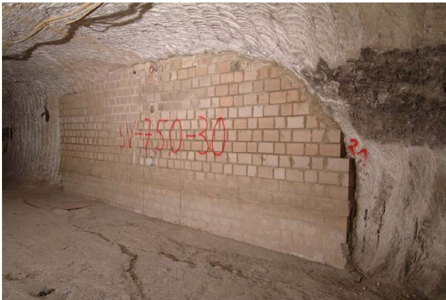
Abb. 4: Verstärkter Verschluss der Kammer 4 auf der 750-m-Sohle.
