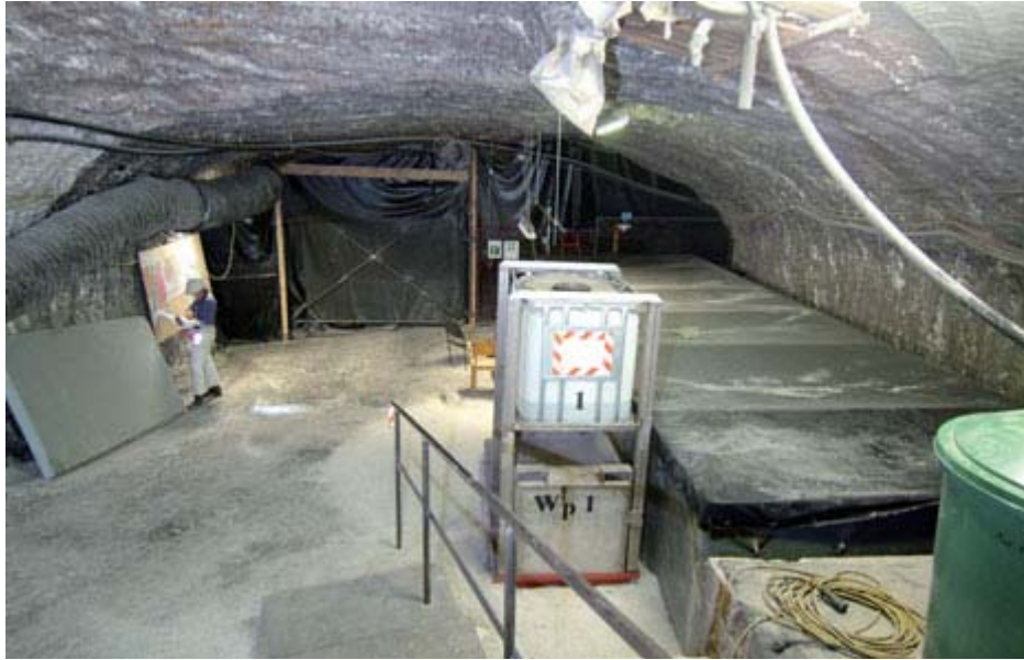
Abb. 3: Hauptauffangstelle für Zutrittslösungen auf der 658-m-Sohle nach den Umbaumaßnahmen.
