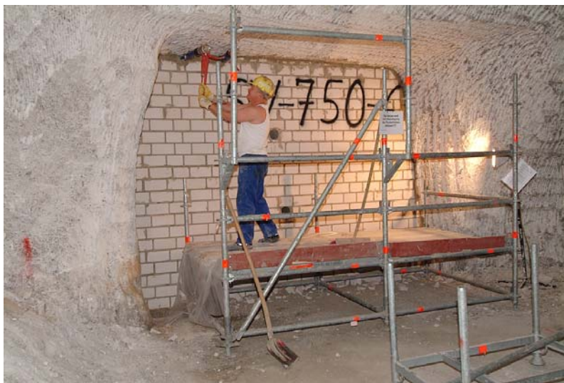
Abb. 8: Verschluss der Kammer 5 auf der 750-m-Sohle.
