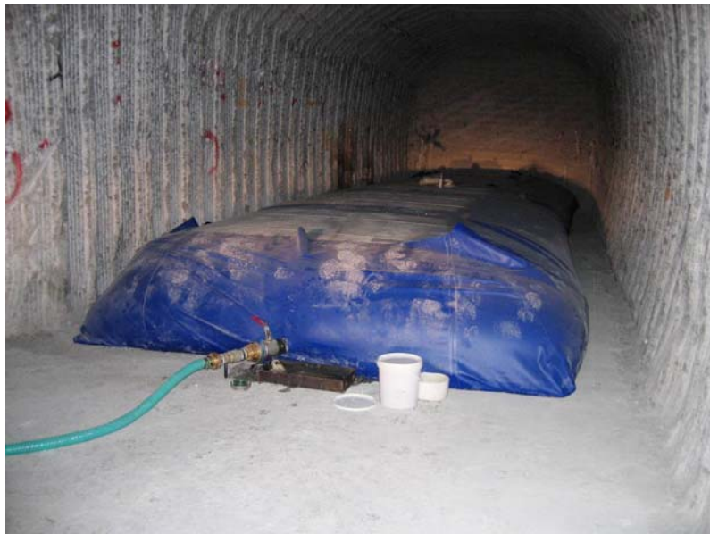
Abb. 9: faltcontainer auf der 800-m-Sohle.
