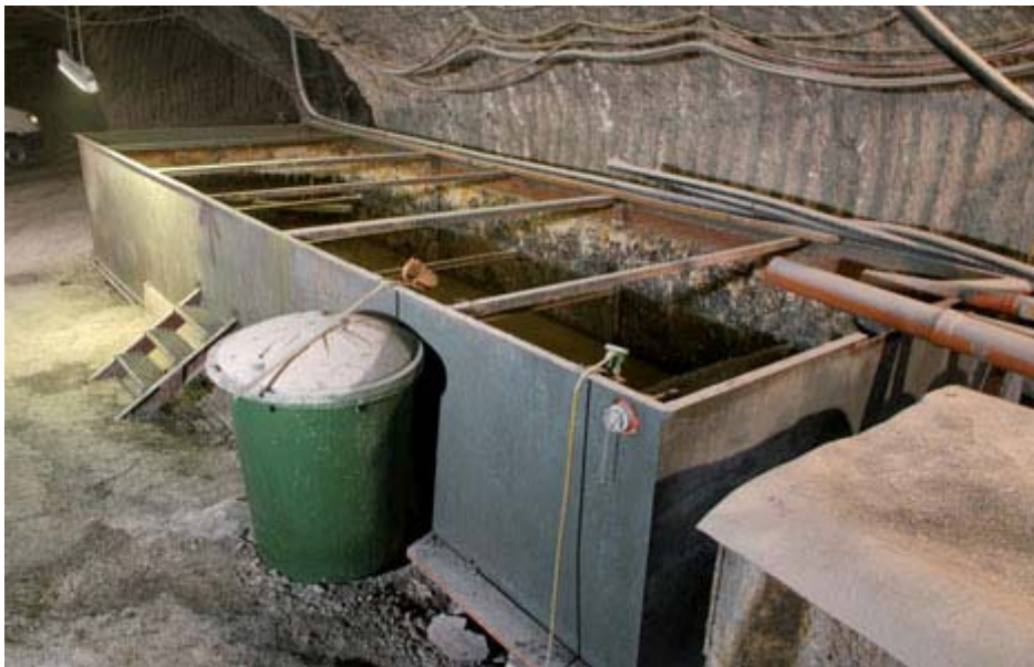
Abb. 2: Hauptauffangstelle für Zutrittslösungen auf der 658-m-Sohle vor den Umbaumaßnahmen.
