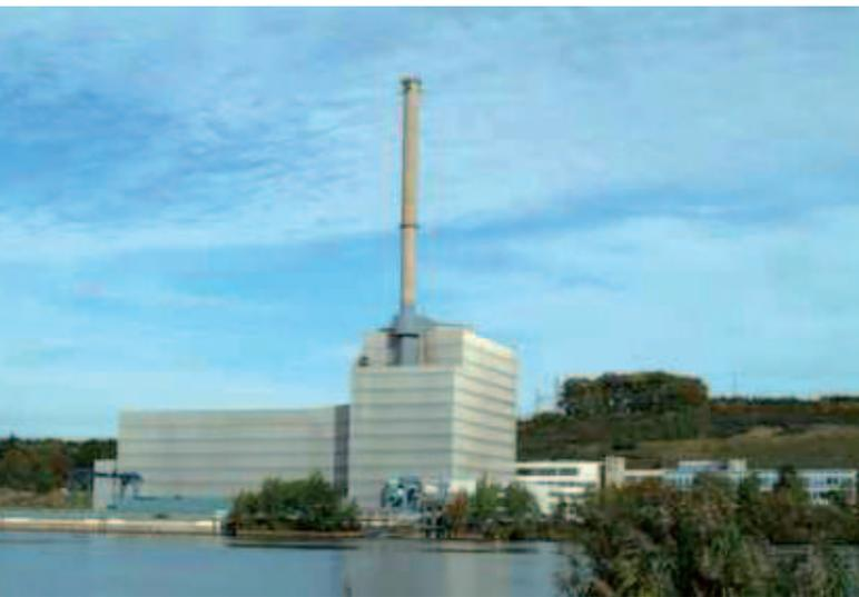
**Das Kernkraftwerk Krümmel ist seit 1983 in Betrieb und ist ein Beispiel für einen Siedewasserreaktor der Baulinie 69**
