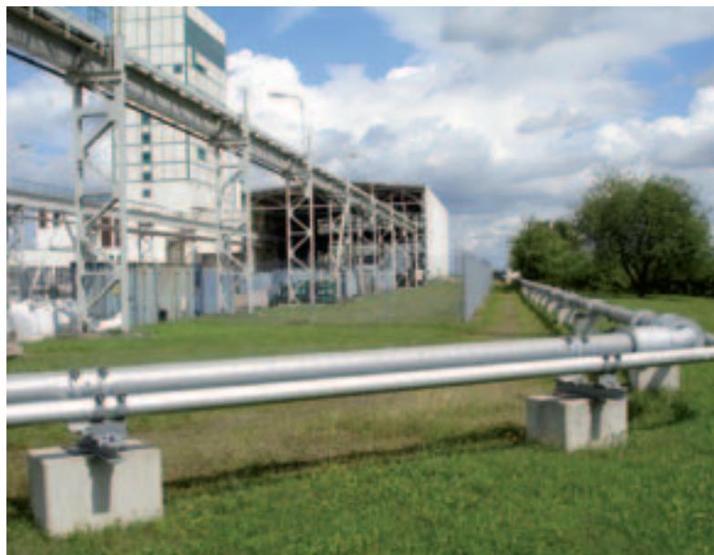
**Förderleitung für die Verfüllung ehemaliger Salzabbaukammern im Zentralteil des ERAM mit Salzbeton**
