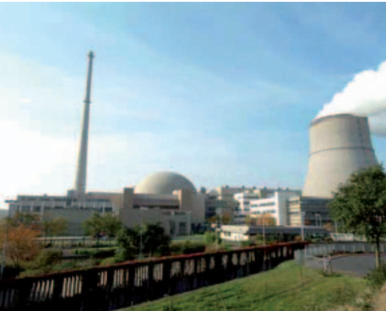
**Das Kernkraftwerk Emsland ist das zweitjüngste Kernkraftwerk in Deutschland und ein Beispiel für einen Druckwasserreaktor der so genannten Konvoi-Anlagen, weil insgesamt drei Anlagen fast baugleich 1988/89 den Leistungsbetrieb aufgenommen haben**
