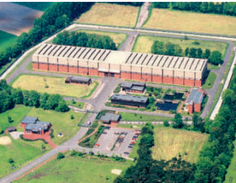
Luftaufnahme des Transportbehälterlagers Ahaus (Foto: BZA)
