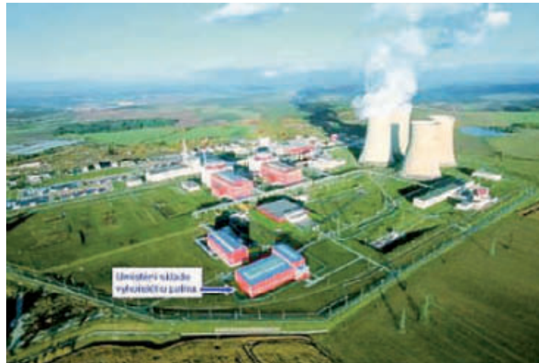
Blick auf das geplante Zwischenlager für abgebrannte Brennelemente am Standort des tschechischen KKW Temelín (Foto: UVE-Konzept/ČEZ)
