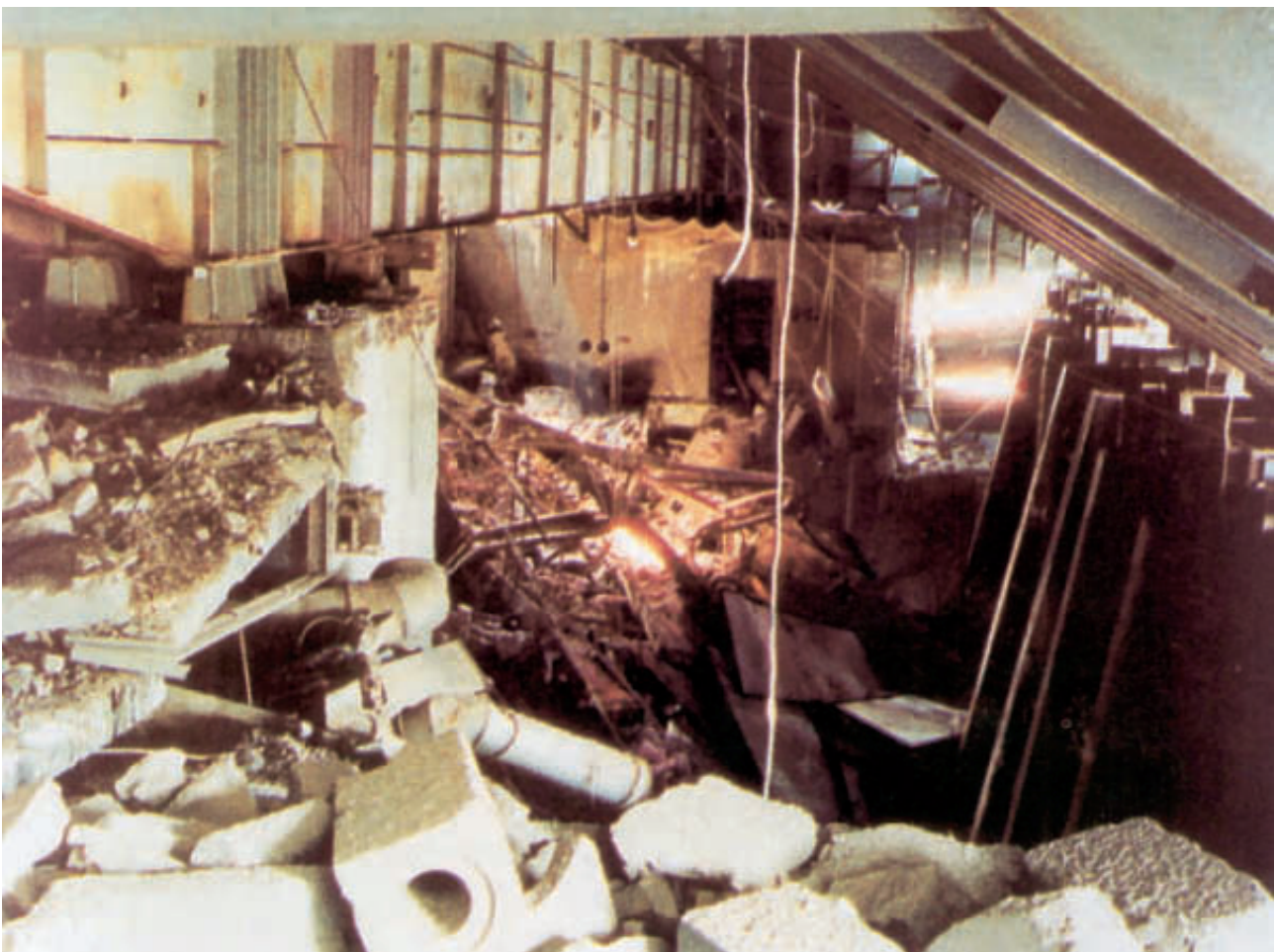
Blick in das Innere des zerstörten Reaktorgebäudes
