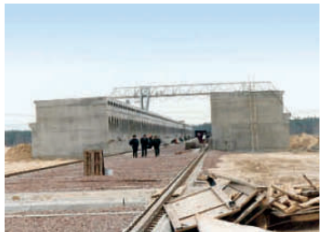
Behälterlager des ISF-2 im Bau
