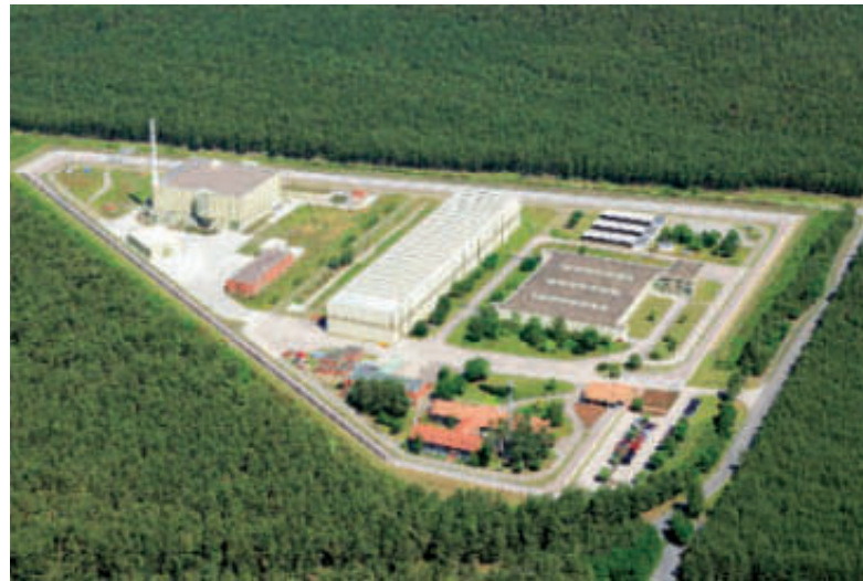
Gelände und Anlagen der Brennelementlager Gorleben GmbH (Foto: BLG)
