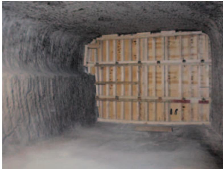
**Holzschalung für die Verfüllung mit Salzbeton im Zugang zum Abbau 3s auf der 4. Sohle**
