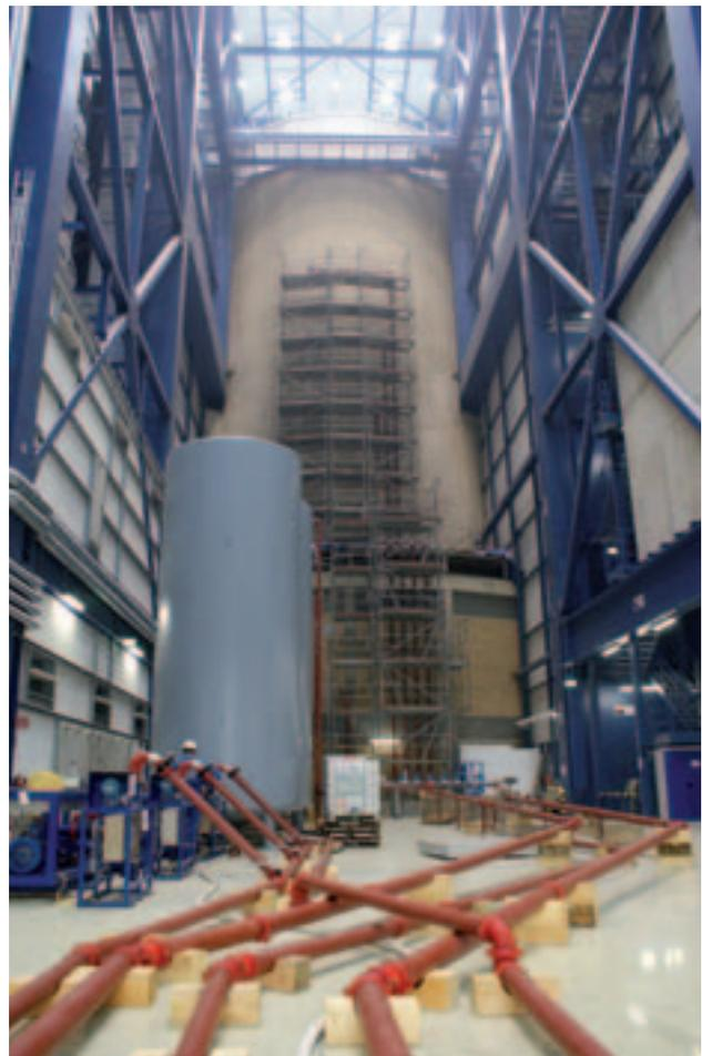
Innenansicht der Materialschleuse des in Stilllegung befindlichen Reaktors AVR in Jülich während der im November 2008 durchgeführten Verfüllung des Reaktorbehälters mit Porenleichtbeton
