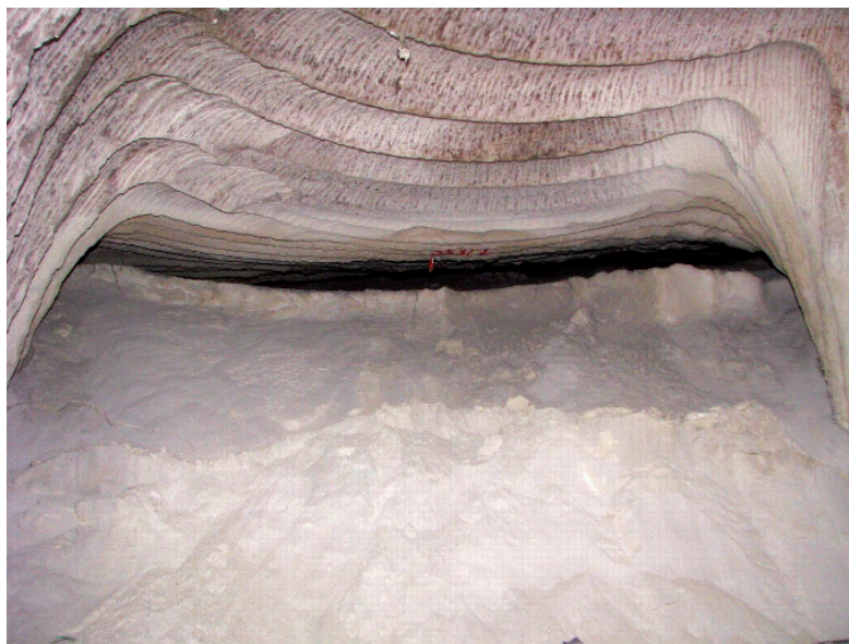
Abb. 8: Firstspalt Abbau 8 auf der 553-m-Sohle vor Erstellung des Verschlussbauwerkes.
