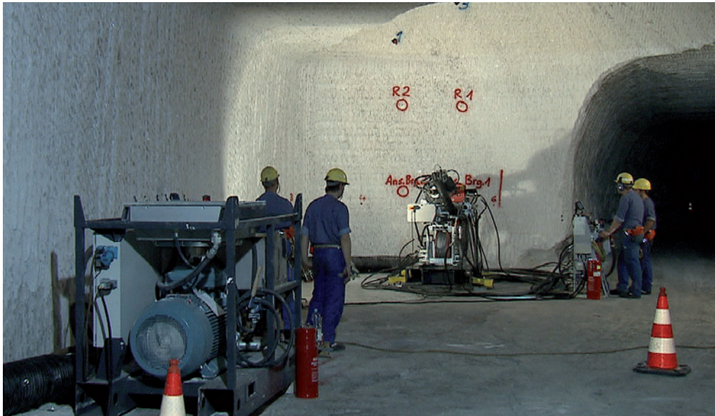
Abb. 2: Beschäftigte der Asse-GmbH bei Arbeiten zur Kalterprobung auf der 800-m-Sohle.
