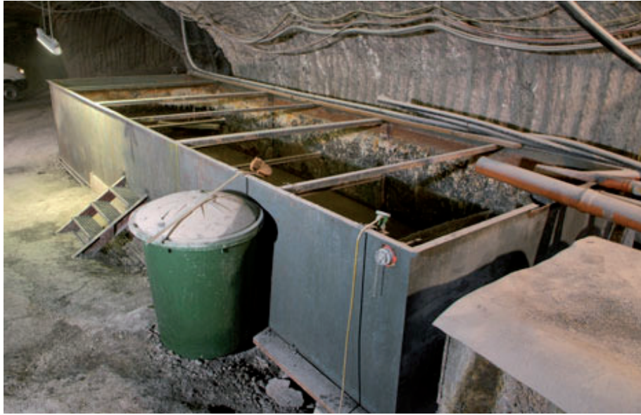
Abb. 5: Hauptauffangstelle für Zutrittslösungen auf der 658-m-Sohle vor den Umbaumaßnahmen.
