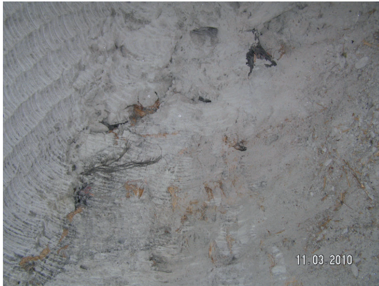
Abb. 11: Vollständig zusammengedrückter Blindschacht 2 auf der 637-m-Sohle.
