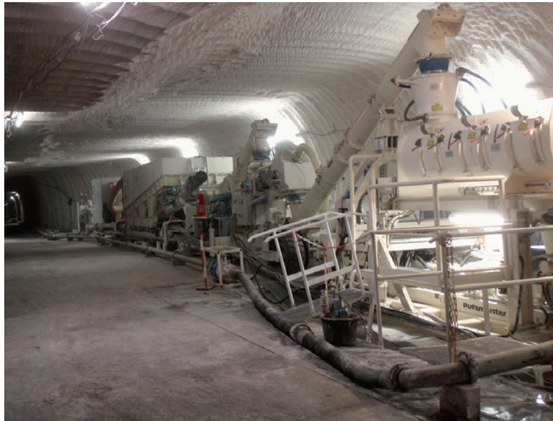
Abb. 9: Semimobile Baustoffanlage zur Herstellung von Sorelbeton für die Firstspaltverfüllung auf der 511-m-Sohle.
