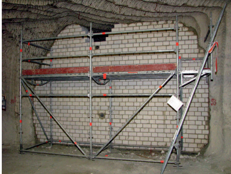
Abb. 10: Bau des Verschlussbauwerkes für Abbau 8 auf der 553-m-Sohle.
