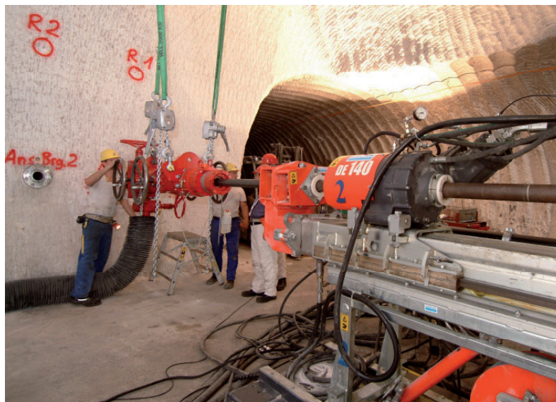
Abb. 15: Der Preventer wird für die Kalterprobung auf der 800-m-Sohle eingerichtet.
