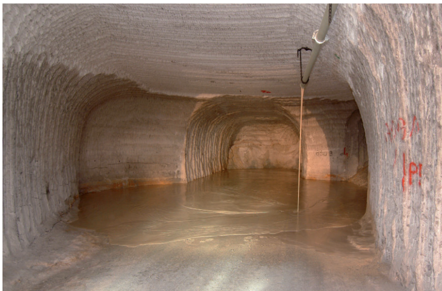
Abb. 7: Nicht mehr genutzte Hohlräume auf der 850-m-Sohle werden mit Sorelbeton verfüllt.
