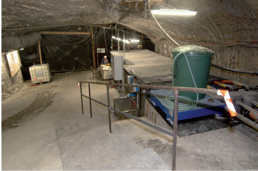
Abb. 6: Hauptauffangstelle für Zutrittslösungen auf der 658-m-Sohle nach den Umbaumaßnahmen.
