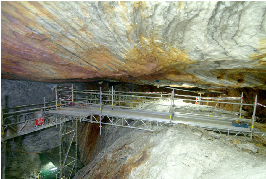
Abbildung 9: Tropfenzählanlage „Abbau 1a“
