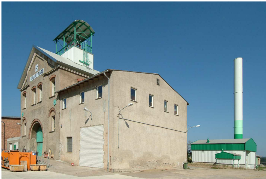
Abbildung 15: Schachthaus und Abwetterbauwerk des Schachtes Marie
