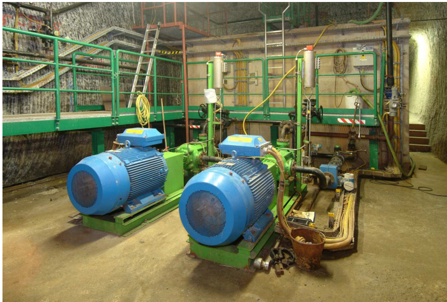
Abbildung 7: Wasserauffangbecken der bGZ mit Pumpen zur Förderung des Wassers nach über Tage
