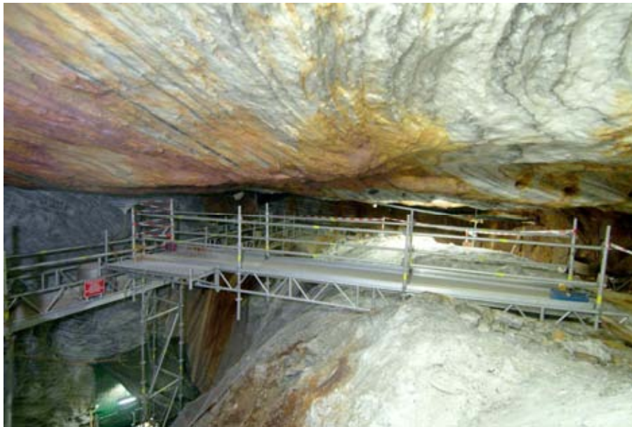
Abbildung 8: Tropfenzählanlage „Abbau 1a“
