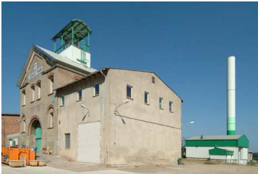
Abbildung 14: Schachthaus und Abwetterbauwerk des Schachtes Marie
