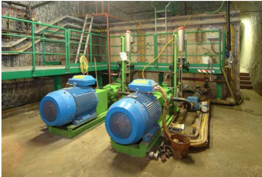
Abbildung 6: Wasserauffangbecken der bGZ mit Pumpen zur Förderung des Wassers nach über Tage
