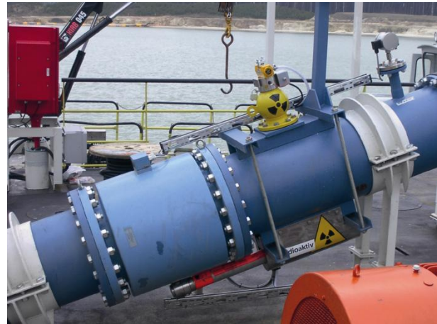
Abbildung 4.2-8: Massendurchfluss-Mess-einrichtung auf einem Saugbagger (Endress + Hauser).
