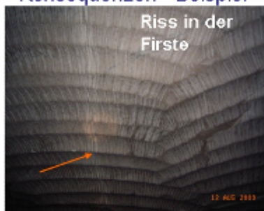
— Rissstrukturen im Georadar in der Firste von Abbau 6a/532
