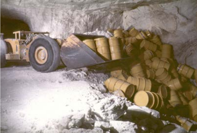
Abb. 2: „Verstürzte“ Abfallbehälter in Einlagerungskammer 8 auf der 750-Meter-Sohle (1975).
