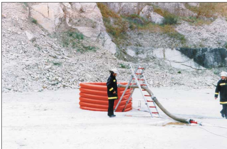
Abbildung KT-4 Einhausung und Anschlußtechnik für Schaumbefüllung
