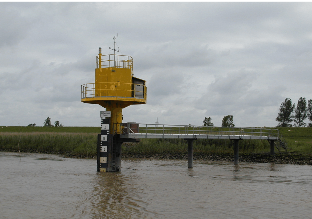
Radioaktivitätsmessstation Terborg/Ems. Warnstelle und Probennahmegeräte für Wasser und Schwebstoff sind auf diesem Pegelturm installiert
