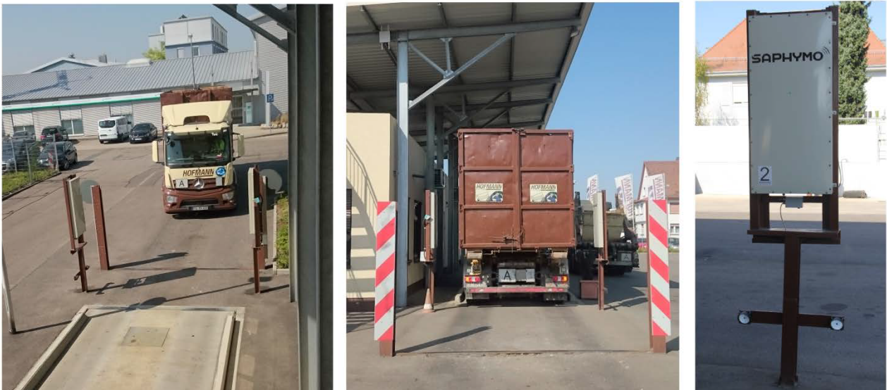
Abbildung 4-2: Saphymo Portalmessanlagen auf dem Firmengelände der Hofmann GmbH
