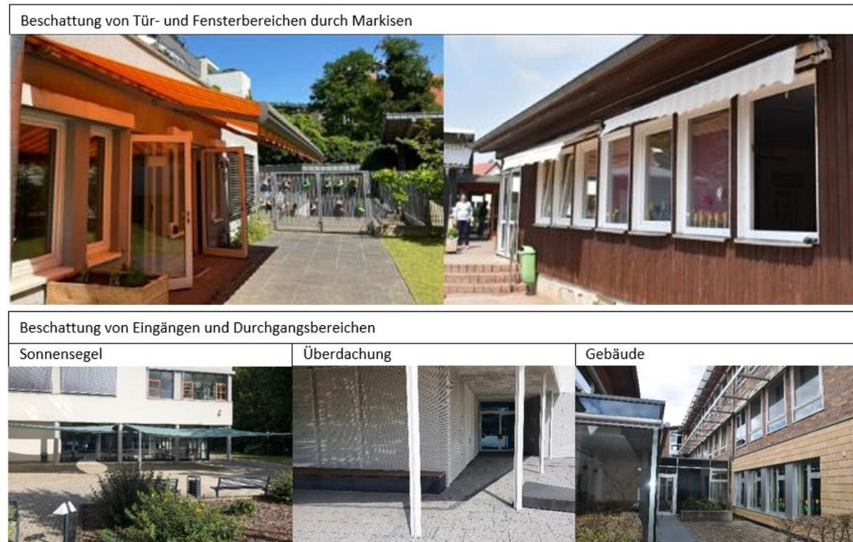
**Abbildung D13.** Beschattung von Tür und Fensterbereichen durch Markisen sowie von Eingängen und Durchgangsbereichen (die oberen beiden Fotos stammen aus Kindertagesstätten, die unteren drei aus Schulen)
