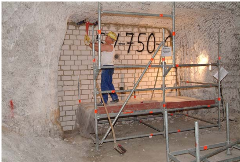
Abb. 8: Verschluss der Kammer 5 auf der 750-m-Sohle.
