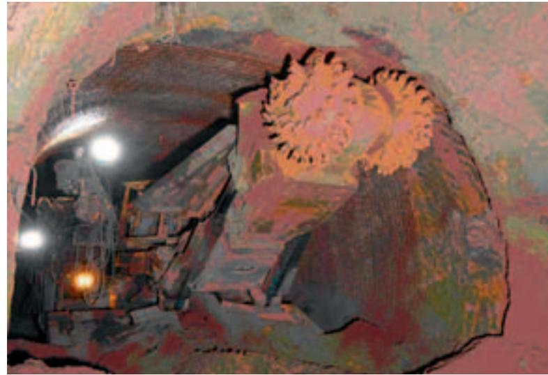
**Raubarbeiten mit einer Teilschnittmaschine für die Sanierung der Grubenbaue**
