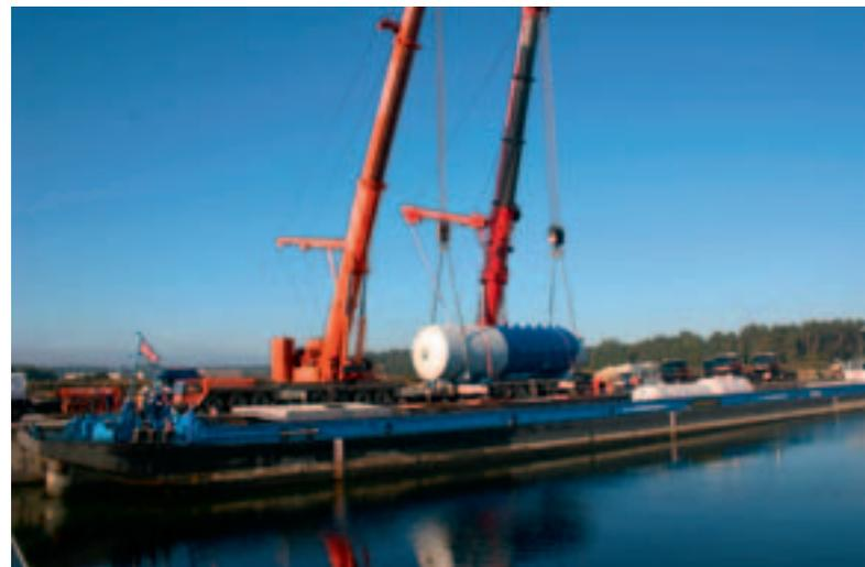
Dampferzeuger auf dem Binnenschiff (Foto: EWN)
