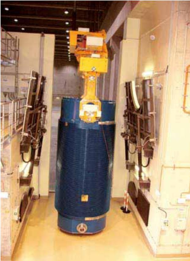
**Einschleusen des Behälters aus der Wartungsstation in die Lagerhalle**
