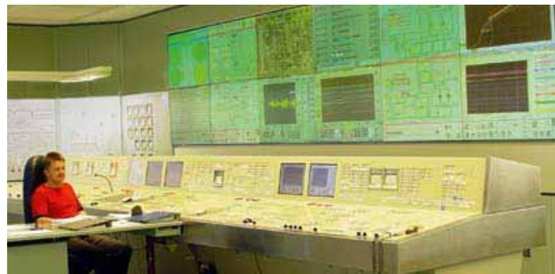
Im KKW ISAR 1 wurden Teile der Warte sowie Teile der Sicherheitsleittechnik unter Verwendung Software-basierter Einrichtungen umgerüstet (Quelle: E.ON Kernkraft GmbH Kernkraftwerk Isar)
