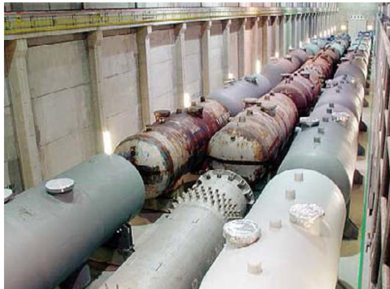
Zwischenlagerung von Komponenten (hier: Dampferzeuger) im Zwischenlager Nord (ZLN) aus den in Stilllegung befindlichen Kernkraftwerksblöcken 1-5 in Greifswald. (Quelle: EWN GmbH)
