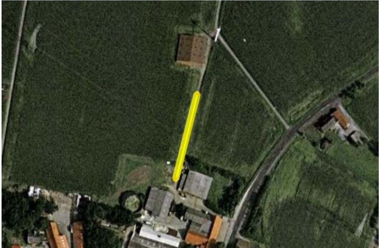
Luftbild: FL380_3a, 380 kV-Freileitung, der Messweg verläuft am linken Rand des Feldweges, der die Trasse kreuzt
