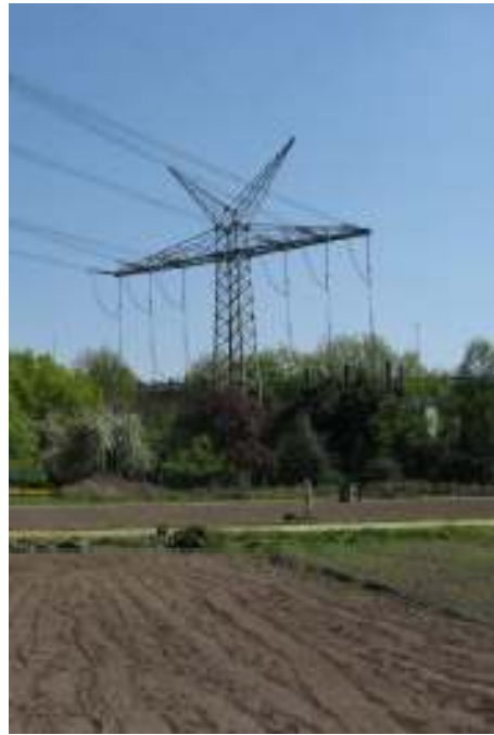
Abspannmast, südöstlich des Messweges
