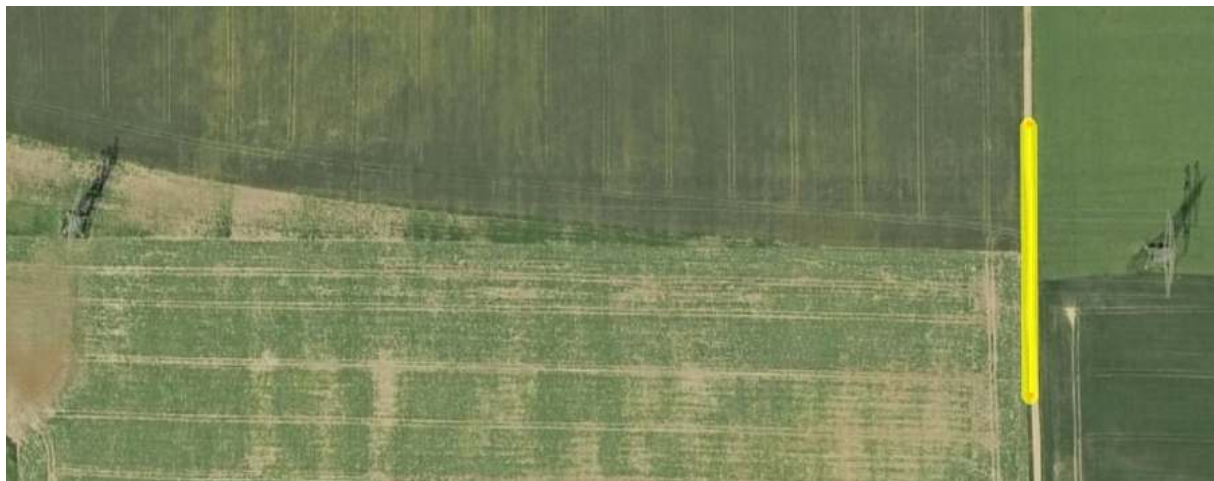
Luftbild: FL380_4b, 380 kV-Freileitung
