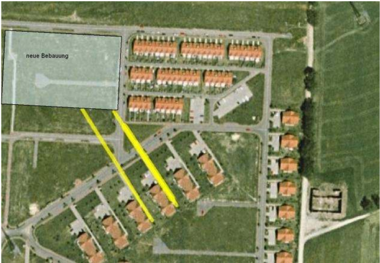
Luftbild: FL380_2, 380 kV-Freileitung, die beiden Messwege verlaufen parallel zueinander und senkrecht zur Trasse, Messweg 1 im April bis 50 m Abstand (dicke Linie) und im August wie Messweg 2 bis zu den Grundstücksgrenzen.
