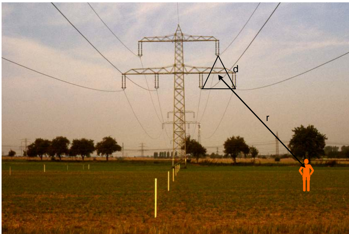
Abbildung 2/8 Überlagerung der Feldbeiträge von drei Phasenleitern
