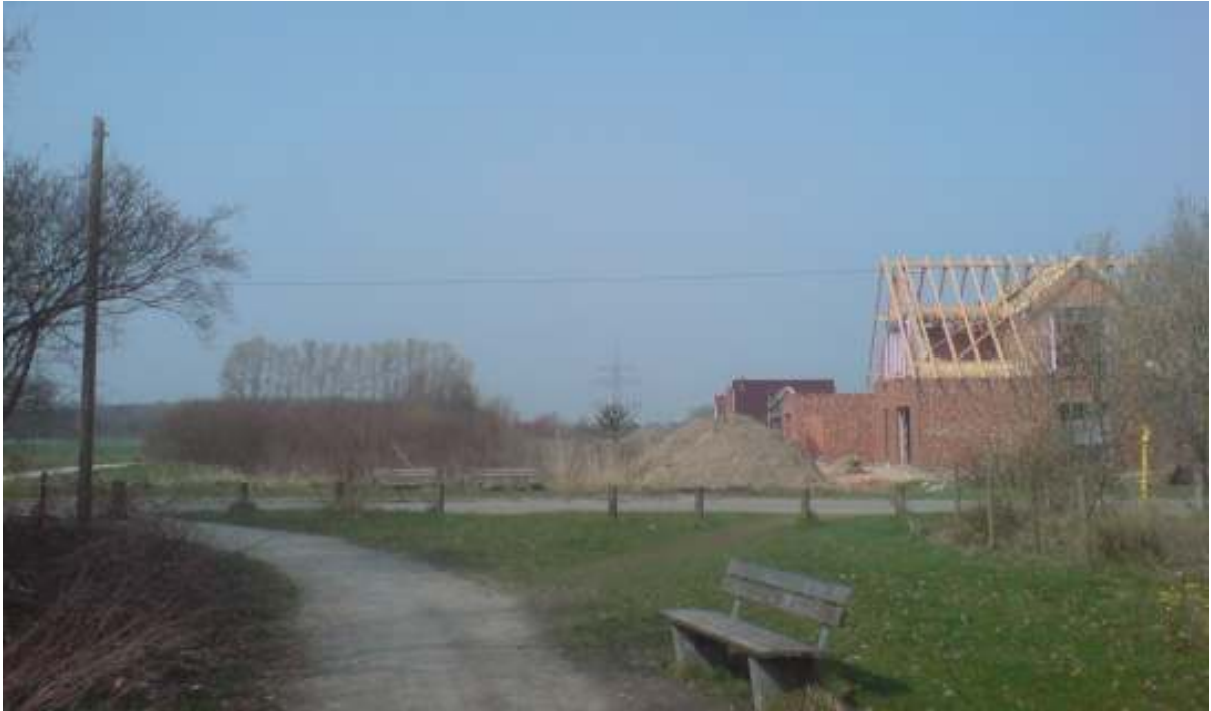
Foto: EK110_2, Blick von Süden, das Erdkabel liegt unter der Grasstreifen neben dem Radweg und weiter nach Norden westlich von den Neubauten, unter den Sandhaufen entlang auf den Abspannmast im Hintergrund zu, der Messweg (a) verläuft auf der Querstraße, der Messweg (b) parallel dazu etwa an der Position des Fotografen
