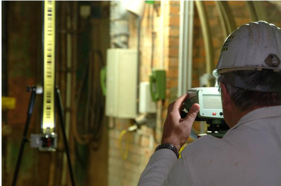
**Abbildung 5: Messung der Firstsenkungsraten**
