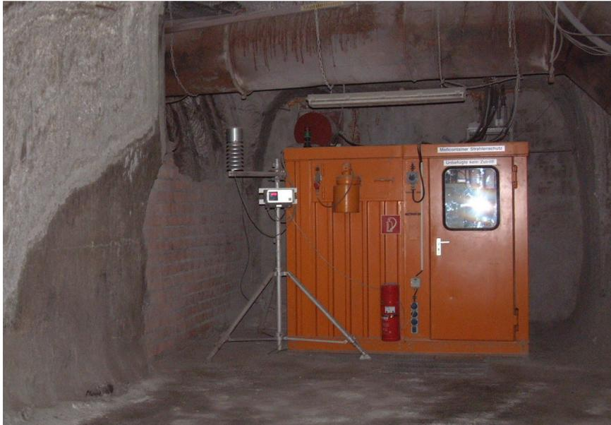
**Abbildung 14: Raumlüftungsüberwachungseinrichtung der Grubenluft im Kontrollbereich**
