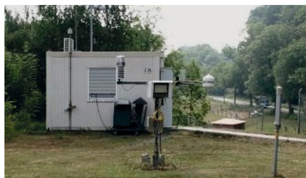
Messstation zur Umgebungsüberwachung und zur Erfassung meteorologischer Daten am östlichen Rand des Betriebsgeländes
