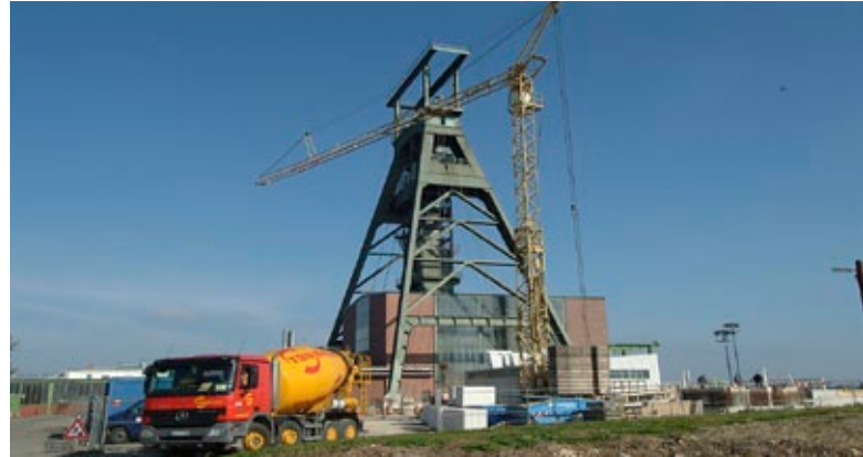
Vielfältige Bauarbeiten wurden auf dem Schachtgelände Konrad 1 durchgeführt
