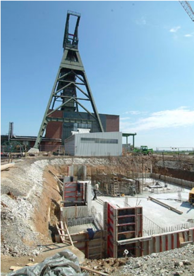
Errichtung des Neubaus des Fördermaschinengebäudes Süd Konrad 1
