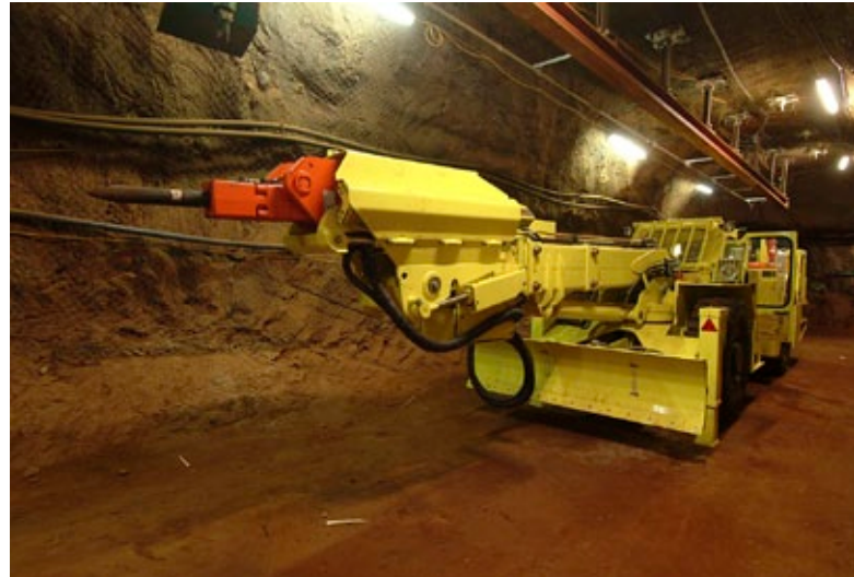
Berauffahrzeug zur untertägigen Streckenauffahrung
