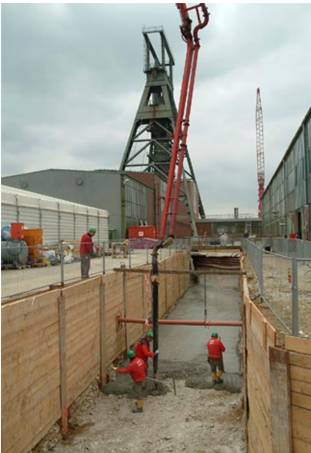
Zur Errichtung des Medienkanals auf dem Schachtgelände Konrad 1 wird die Bodenplatte gegossen
