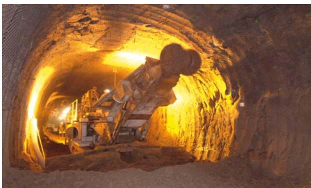
Teilschnittmaschine im Einsatz unter Tage im Schacht Konrad
