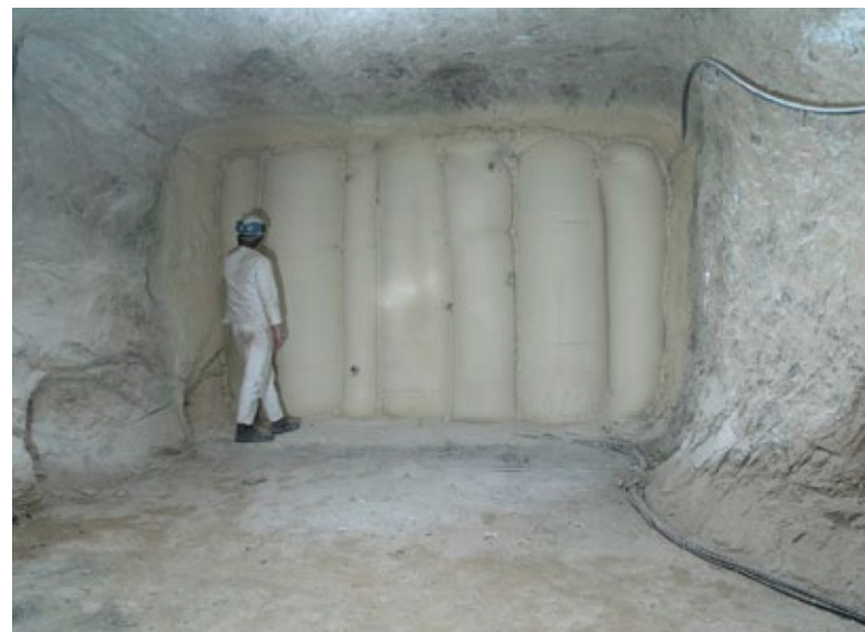
Verschlussbauwerk gegen das Auslaufen von Versatzmaterial
