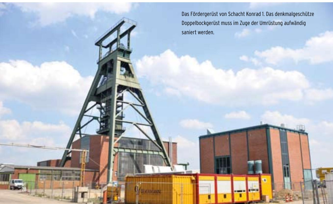
Das Fördergerüst von Schacht Konrad 1. Das denkmalgeschützte Doppelbockgerüst muss im Zuge der Umrüstung aufwändig saniert werden.
