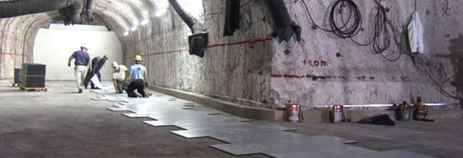
Einrichtung der Bohrstelle mit dekontaminierbarem Bodenbelag
