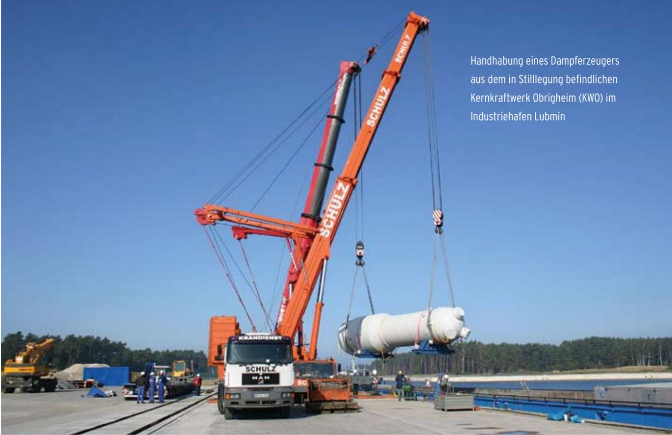
Handhabung eines Dampferzeugers aus dem in Stilllegung befindlichen Kernkraftwerk Obrigheim (KWO) im Industriehafen Lubmin
