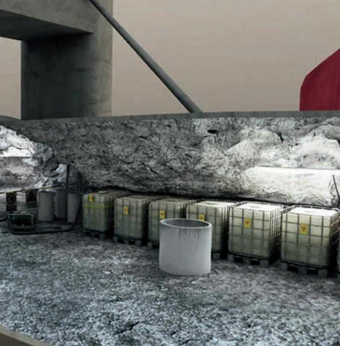
Die kontaminierte Flüssigkeit wurde abgepumpt und in speziellen Behältern verwahrt.
