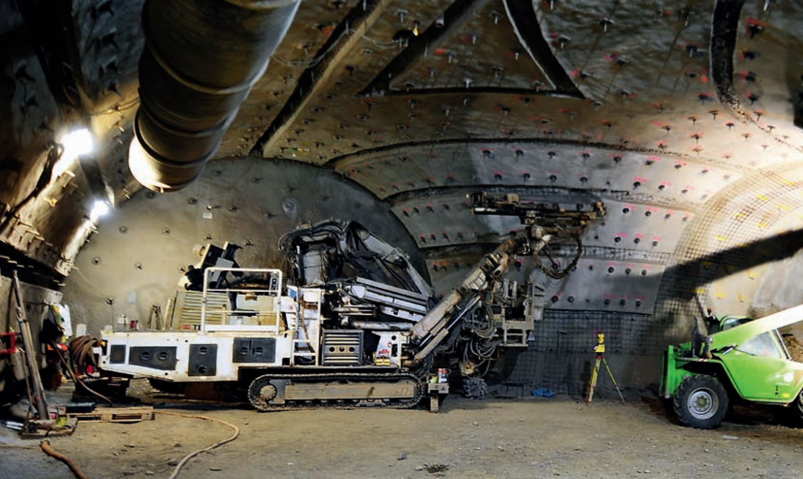
Vorläufiger Spritzbetonausbau im Abzweig zur Einlagerungstransportstrecke
