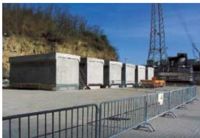
Interimslager Neckarwestheim, unter jeder Umhausung aus Stahlbeton wird ein Castor-Behälter gelagert
