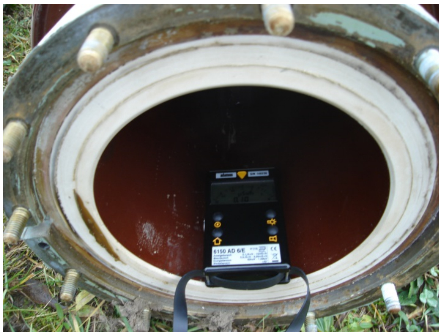
Abbildung 5-5: Messung der ODL im Inneren eines Hochspannungsisolators mit dem Messgerät AD6/E
