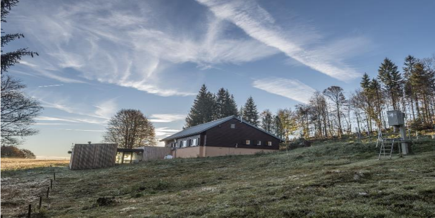
Abbildung 25: Standort Schauinsland bei Freiburg
