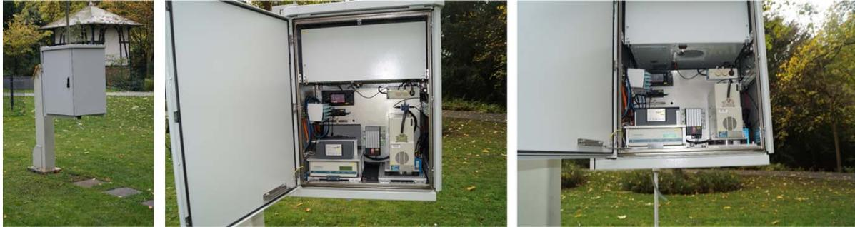
Abb. 3: Aufbau des neuen Systems mit Detektor, VKA, Klimaanlage, Heizmodul und Steuerung
