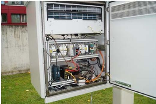
Abb. 4: Stromanschlüsse (USV, normal), Netzwerkkomponenten und Luftzuführung, Klimaanlage (filtrierte Zuluft)
